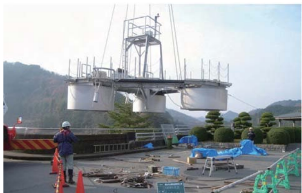
浅層曝気循環設備の設置(室生ダム)
