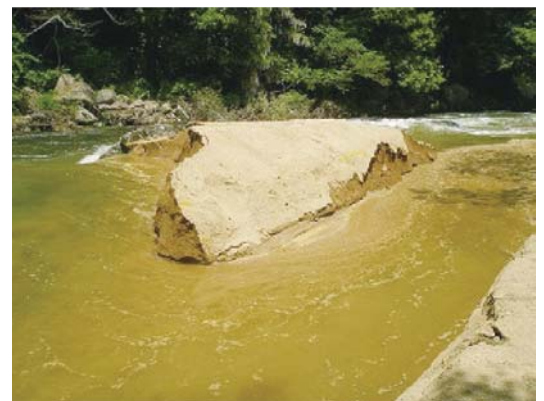
フラッシュ放流による土砂還元状況(室生ダム)
