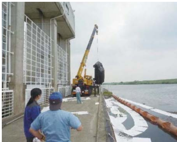
車両の搬出(秋ヶ瀬取水堰[利根導水総合事業所])
