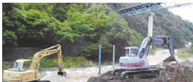
土砂の攪拌・投入状況
