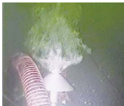
散気管を取り付けた頭部の浅層曝気状況
