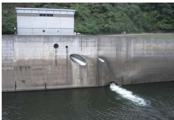
管理用発電所(日吉ダム管理所)
