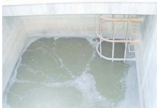
微細気泡発生装置の運転状況
