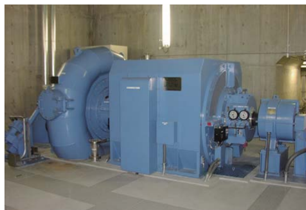
施設管理用水力発電設備(日吉ダム管理所)
