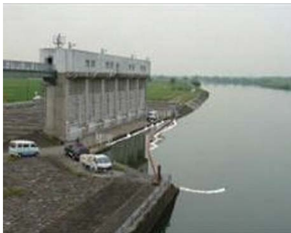
オイルマットの設置(秋ヶ瀬取水堰[利根導水総合事業所])
